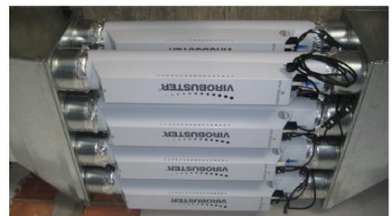
Optionale Anschlussadaper installieren - Modul einsetzen - fertig!
