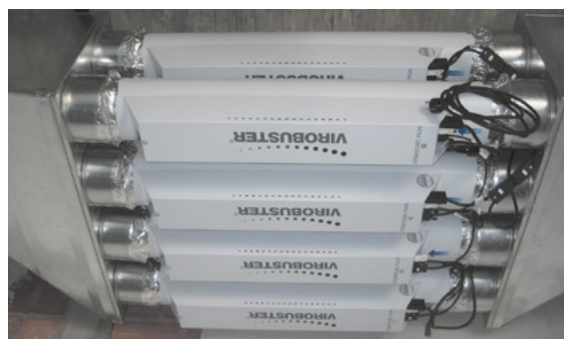
VIROBUSTER® STERITUBES®-Module, als 2x4 Cluster in den Luftkanal eingebaut (LOG 3,6 – 99,98%ige Reduktion)
